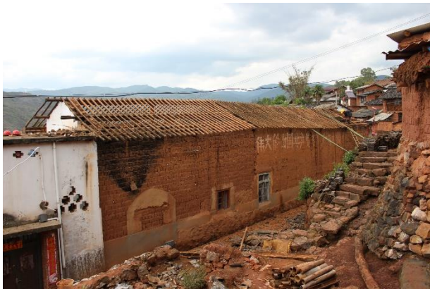
現有房屋拆除
