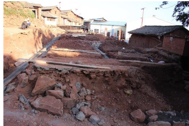
基礎挖掘及場地平整
